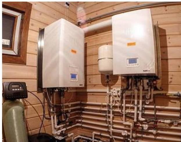
Кроме того, такое оборудование использует погодозависимое регулирование: внешние и внутренние датчики позволяют системе самостоятельно обеспечить заданную температуру – свою для помещений различного назначения.
